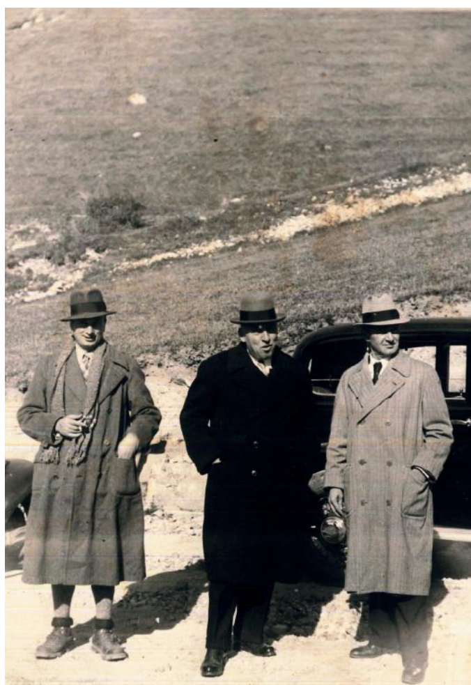
A sinistra l'ingegner Giuseppe Stancari, il direttore lavori in val Sarentina
